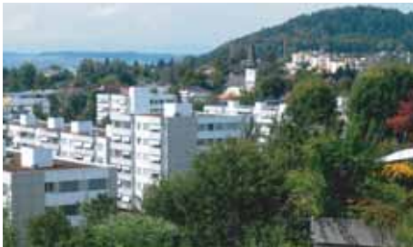
Hühnerbühlstrasse, Bau Ende der Sechzigerjahre
