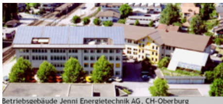
Betriebsgebäude Jenni Energietechnik AG, CH-Oberburg
